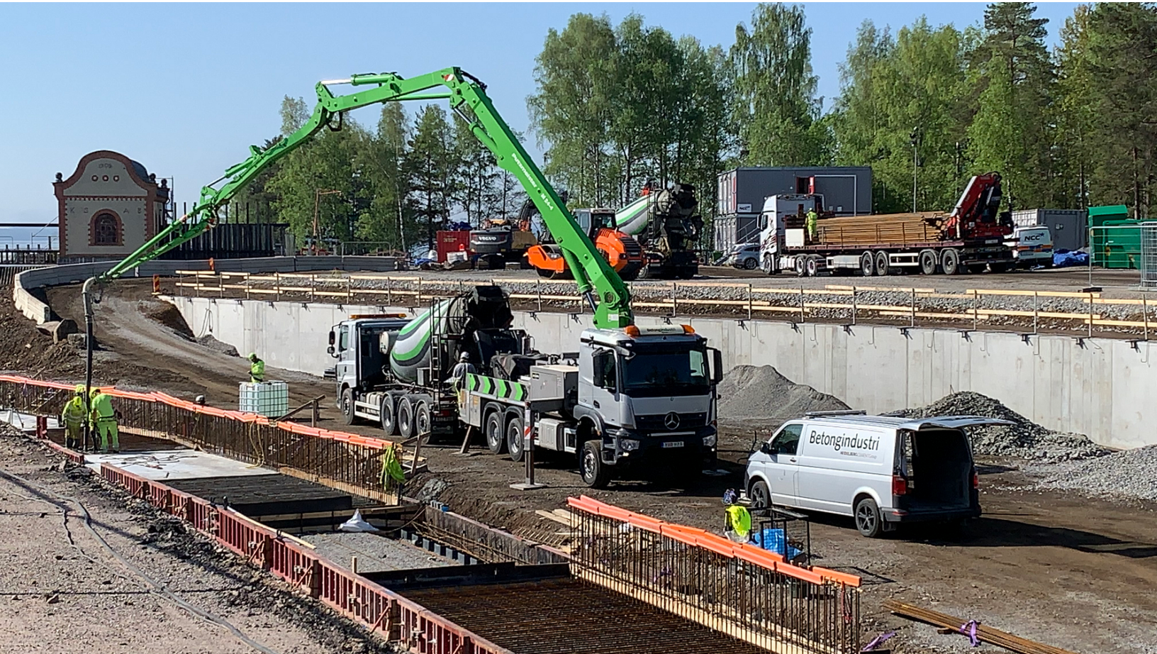
Flödesfrämjande åtgärder vid Korsnäsdammen i Falu kommun.
